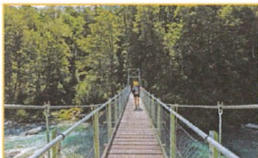
Doc. 4 Passerelle piétonne.
