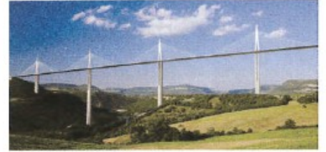
Viaduc de Millau.
