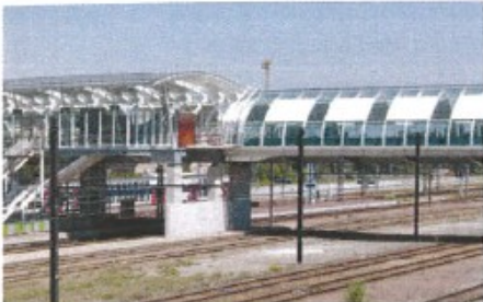
Passerelle de la gare de Massy.
