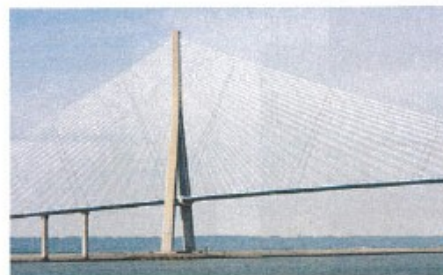
Pont de Normandie.
