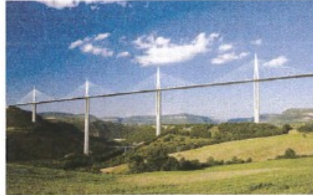
Viaduc de Millau.
