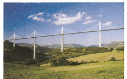
Viaduc de Millau, 2004.
